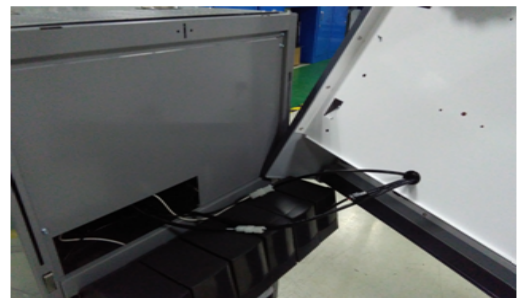
断开灯电源线进线，阀电源进线，阀线接头；
